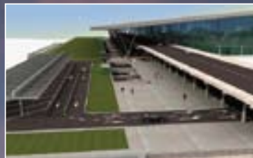
Nueva terminal del Aeropuerto de Santiago
